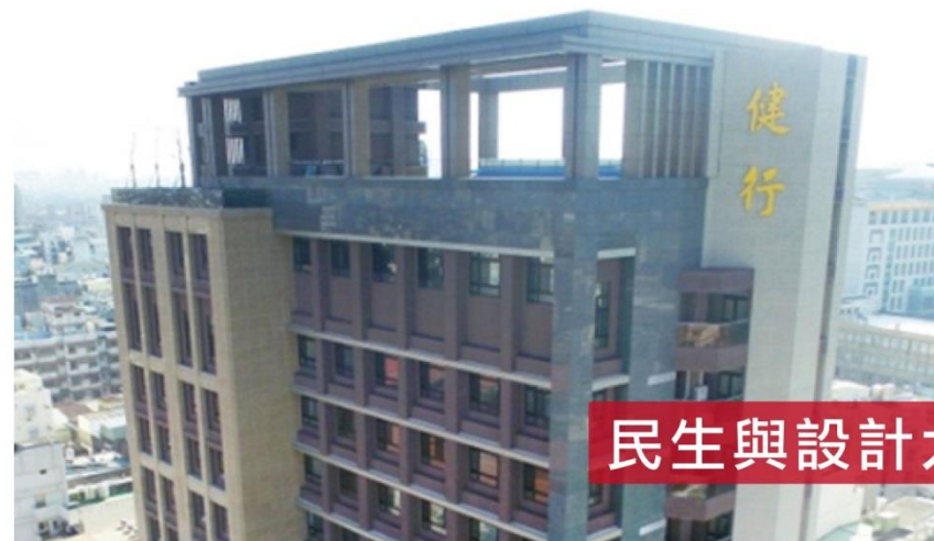
彩繪新建社團大樓牆面
